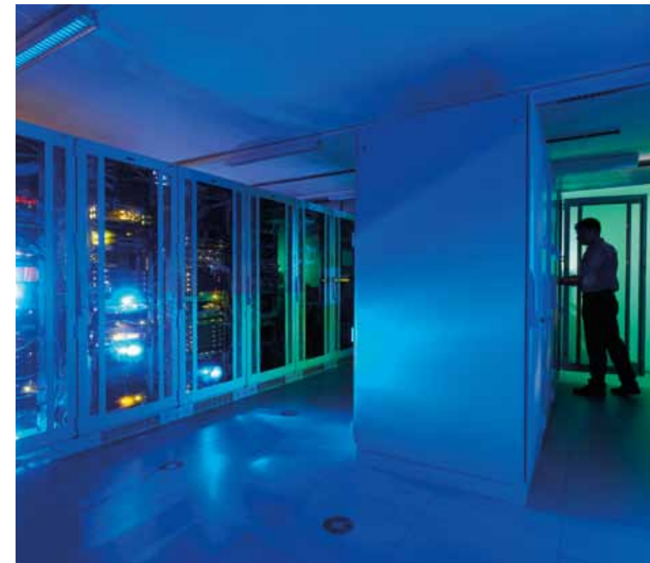
Das Rechenzentrum von Lotto Baden-Württemberg ist auf modernstem Stand. Hier laufen die Spielaufträge aus dem Südwesten zusammen.
