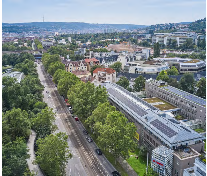
Hochleistungs-Solarmodule auf den Dächern der Unternehmensgebäude produzieren seit Sommer 2021 grünen Strom. Dies war auch ein Thema der Nachhaltigkeitskommunikation.
