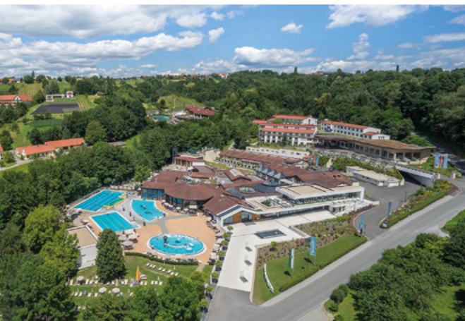
Die Therme Bad Waltersdorf wird täglich mit 1,9 Millionen Litern Heilwasser versorgt.
