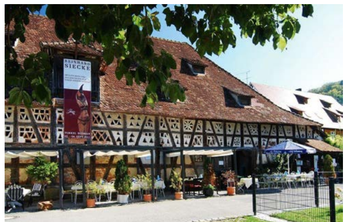
Das Dach des historischen Schlosstorkel in Bodman-Ludwigshafen am Bodensee kann auch dank 100.000 Euro aus Mitteln der Lotterie GlücksSpirale saniert werden.
